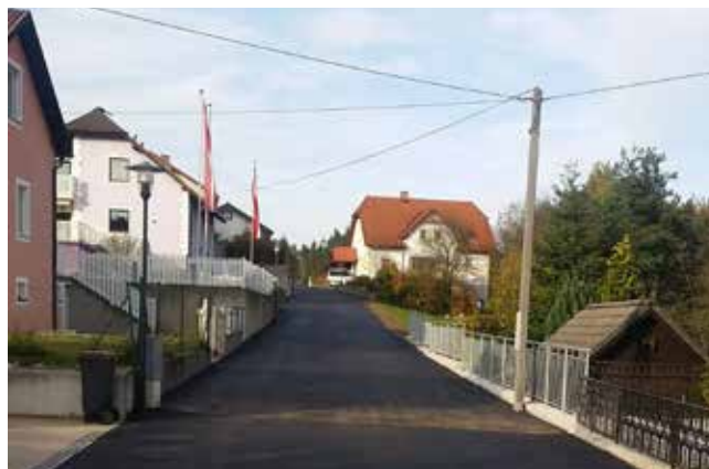
Neu asphaltierte Straße von der Pizzeria bis EVN-Siedlung in Peygarten-Ottenstein
