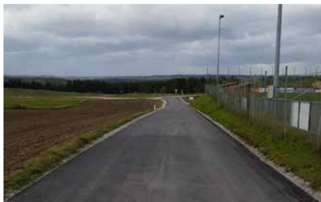
Neu asphaltierte Straße neben dem Sportplatz in Rastendorf
