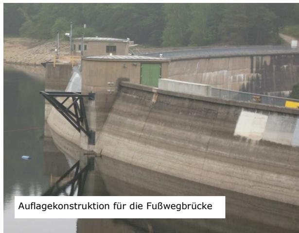
Auflagekonstruktion für die Fußwegbrücke
