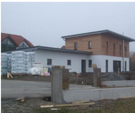
Bild: Errichtung eines Einfamilienhauses (Fam. Bachner)
