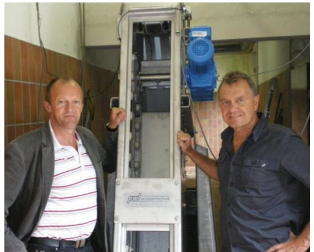
Bild: Monteur von der Firma PWL Anlagenbau und GGR Josef Dastel
