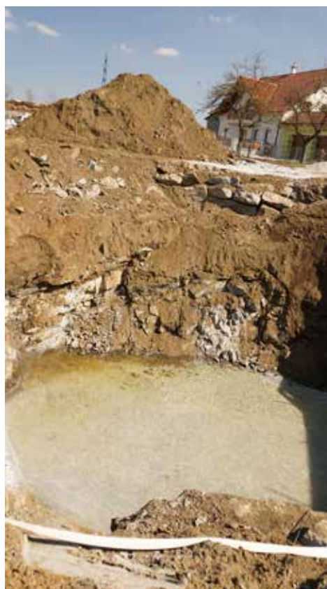
Foto: Baugrube Retentionsbecken Gruber
